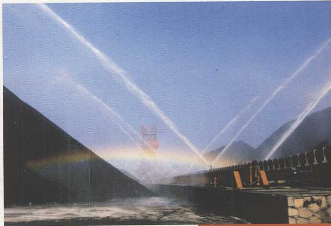
公司承包的秦皇岛煤码头洒水除尘系统工程
