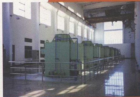
由公司承包获上海市政工程金奖的上海苏州河合流污水二期SB泵站工程
