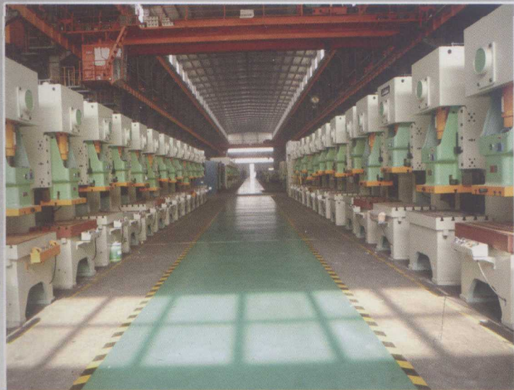
固定台压力机装配现场
