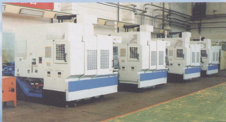
加工中心组装现场
