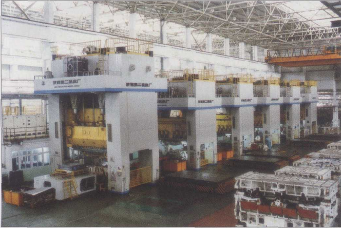
● 由1台LD4—1250/750型闭式四点双动拉伸压力机和4台JB39—1000—T1型、1台JC39—1000型闭式四点单动压力机组成的的大型冲压生产线(安装在南京菲亚特汽车有限公司)。
