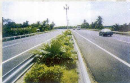
CNMTC高新技术, 使用改性沥青铺设的海南省东线高速公路
