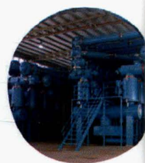
超高压 363~800kV GIS 气体绝缘金属封闭开关设备
