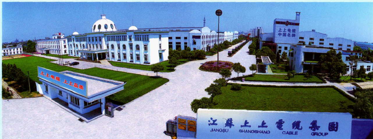
江苏上上电缆集团南厂区概貌图
