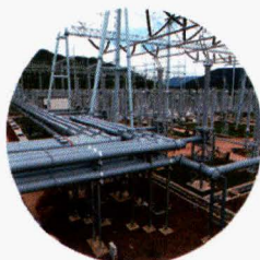
GIL 刚性气体绝缘输电线路
