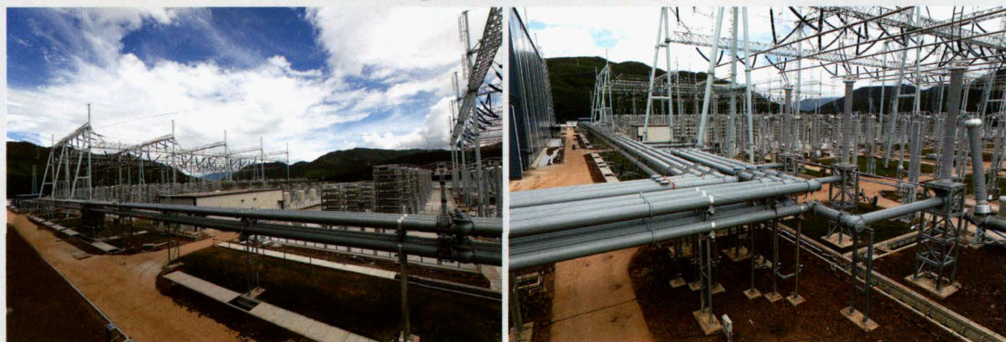
运行在滇西北 ±800kV 新松换流站的 550kV GIL
