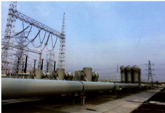
运行在淮南—南京—上海特高压交流输电工程苏州站的1100kV GIL
