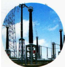
特高压 1100kV GIS 气体绝缘金属封闭开关设备
