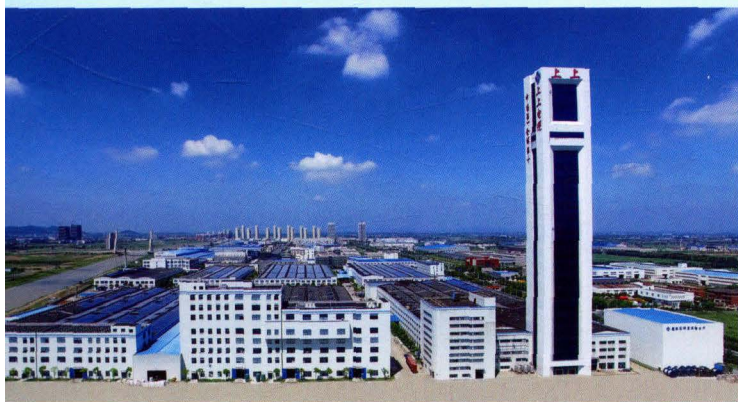
上上电缆西厂区航拍图
