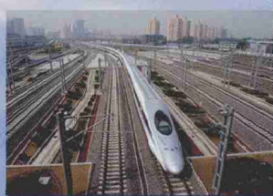
京沪高铁工程
