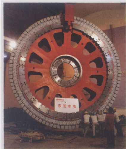
清水塘电站转子现场吊装
