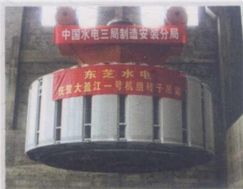
大盈江电站转子现场吊装
