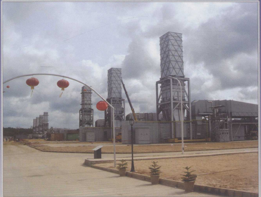
安装在尼日利亚8套6B燃气轮发电机组
