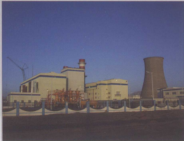
9E燃气轮机在青海格尔木燃气电厂运行
