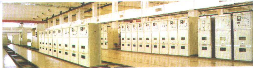
中压开关柜装配车间
