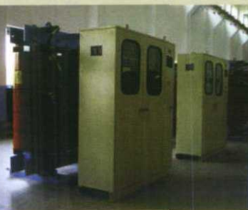
有载干式配电变压器
