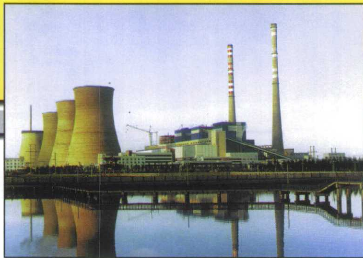
北京巴·威公司为达拉特电厂制造的330MW锅炉- 图为330MW机组锅炉外景
