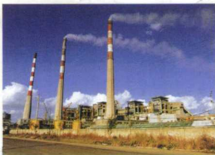
山东龙口670t/h电站锅炉
