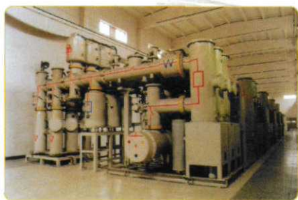
ZF6-220 型 SF6 封闭组合电器 (GIS) 在天津红旗路变电站运行
