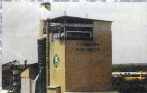
出口印尼的1000t/d碱回收锅炉
