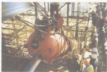
现场吊装设备
