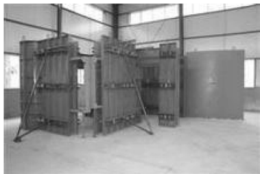
图 1-1 组合式钢模板
