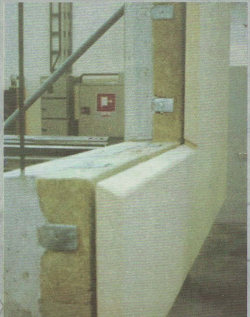
图 C-04 保温装饰一体化墙板
