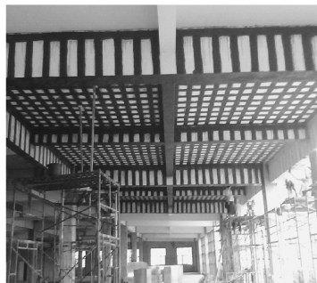
图 1.8 碳纤维加固梁板
