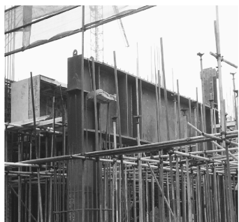
图 1.9 组合型钢梁施工
