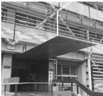
图 1.7 用纤维增强混凝土制作 25mm 厚雨篷
