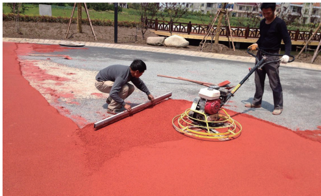
图 1-10 透水性混凝土的现场铺设
