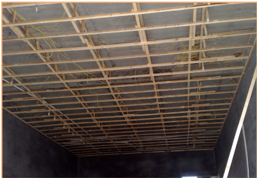
图1-1 卧室木龙骨吊顶
