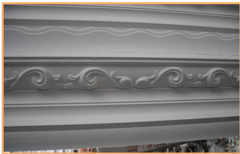
图1-19 浮雕花纹凹凸应在10mm以上
