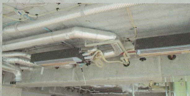
图 C-08 设备与管线设计 —— 集成式吊顶及管线布置
