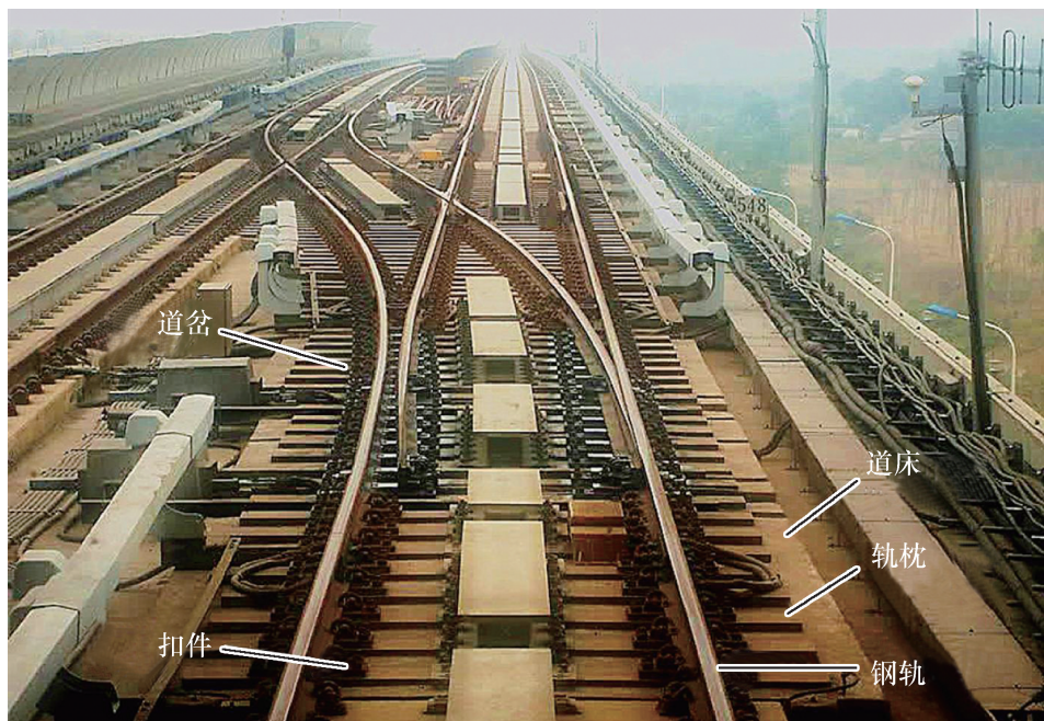
图 1-3 城市轨道交通轨道
