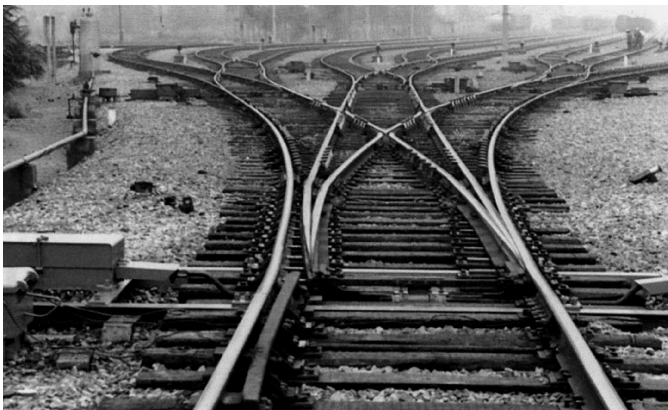
图 1-14 三开道岔实物
