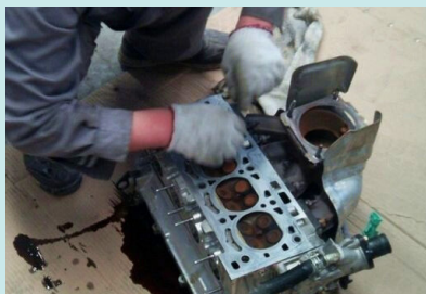
图 1-5 清洁气缸盖表面
