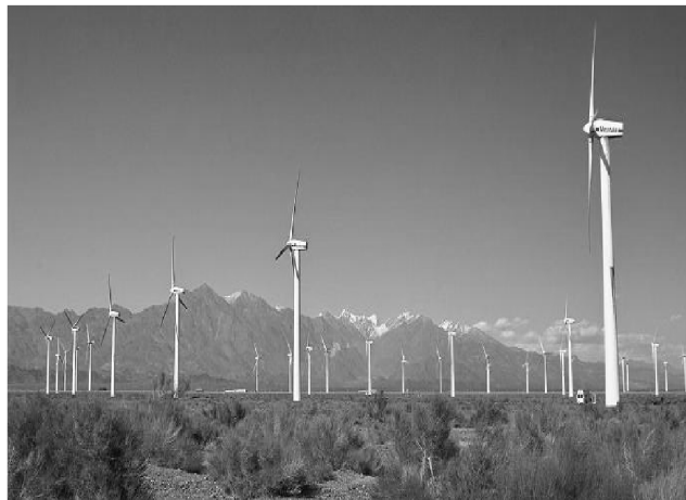
图 1-3 三叶片上风向水平轴风力机
