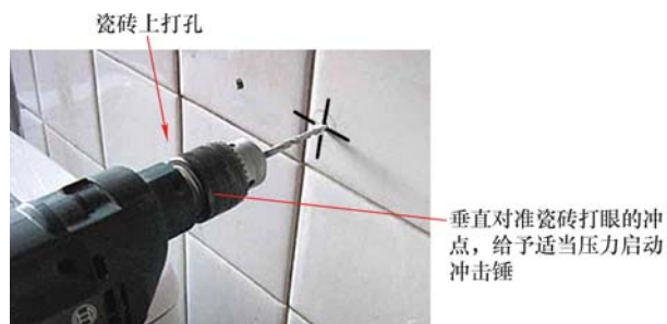
图 1-9 启动冲击锤打孔
