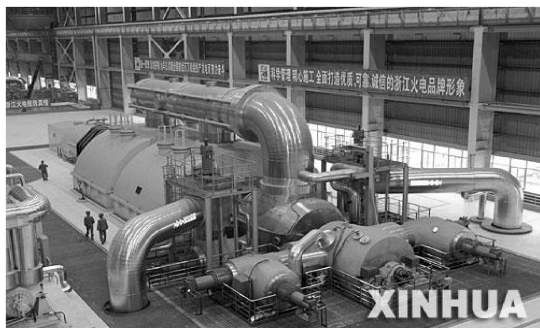
图 1-1 首台国产百万千瓦超超临界燃煤机组
