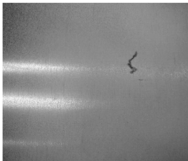
图1 着色检测后的裂纹形态
