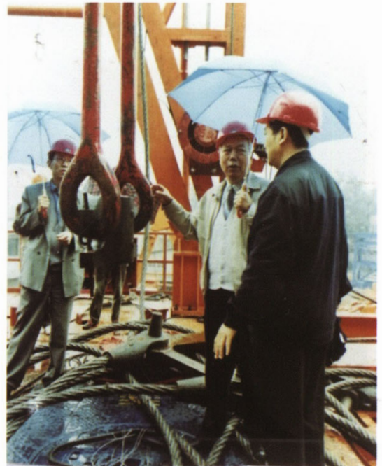
现场调研轻型吊环吊卡的使用情况
