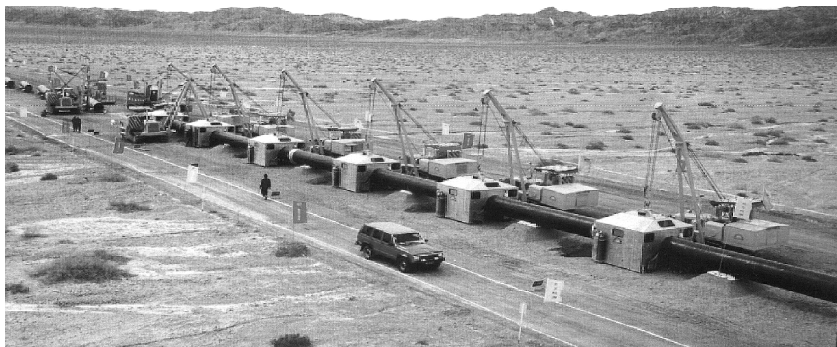
图 1-1 管道自动焊接机械化流水作业
