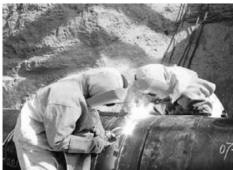
图 1-7 西气东输工程管道焊接
