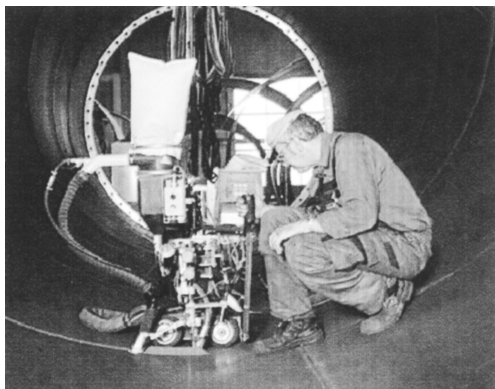
图 1-5 小车式机械化埋弧焊设备全貌
