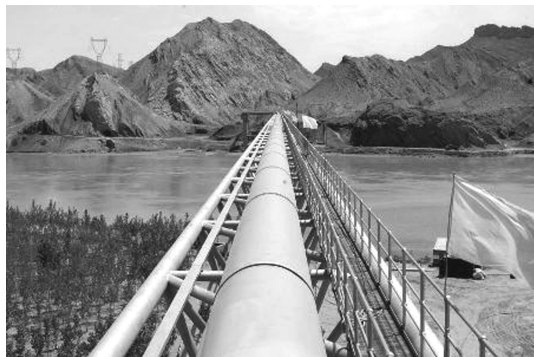
图 1-9 西气东输一线中卫黄河跨越工程
