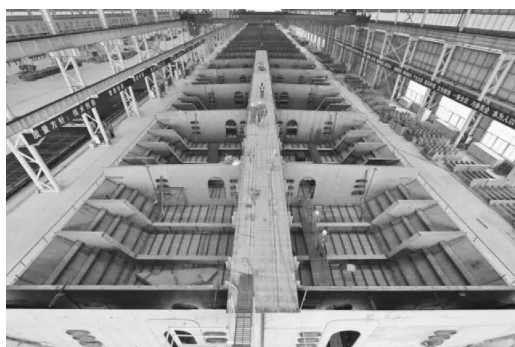
图 1-35 钢箱梁顶板拼装现场
