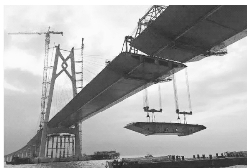
图 1-37 港珠澳大桥“合龙”
