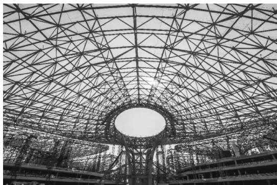
图 1-2 北京新机场的局部网架结构
