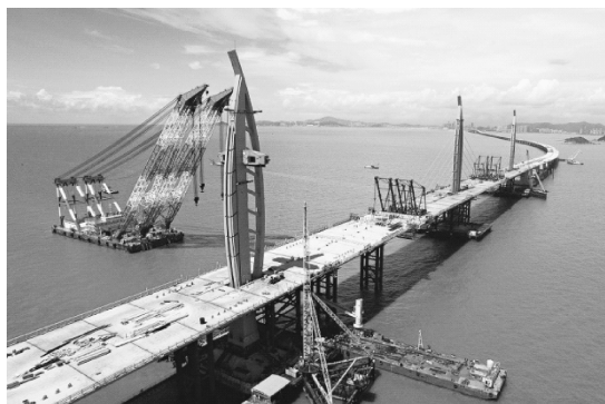
图 1-27 建造中的港珠澳大桥
