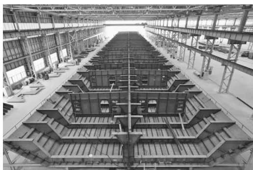
图 1-34 钢箱梁横、纵隔板拼装
