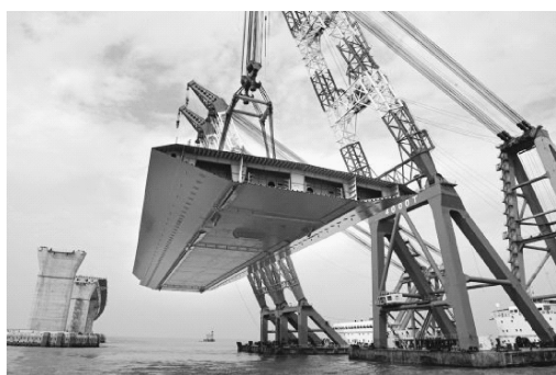
图 1-36 钢箱梁海上吊装
