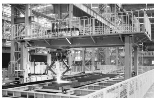
图 1-33 横隔板自动焊接
