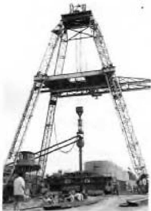
◀ 图 10-1 煤矿竖井钻井法凿井施工现场
