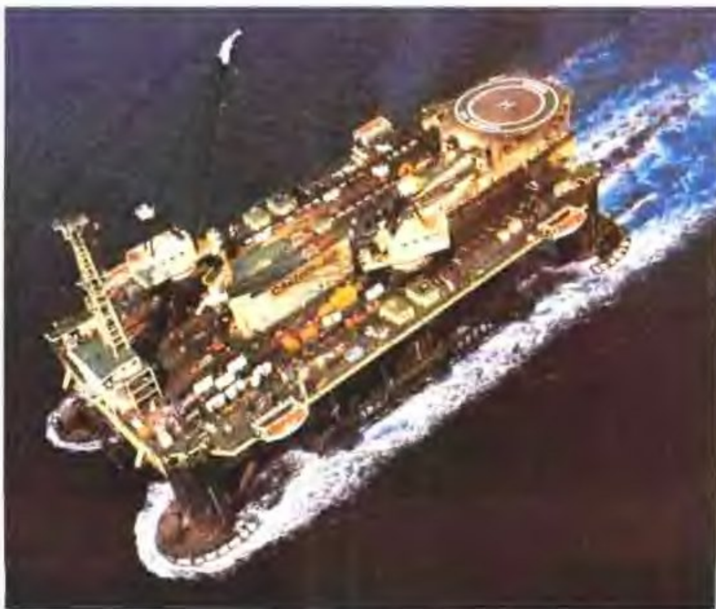
号称“民用航空母舰”的半潜式深海管道铺设船
