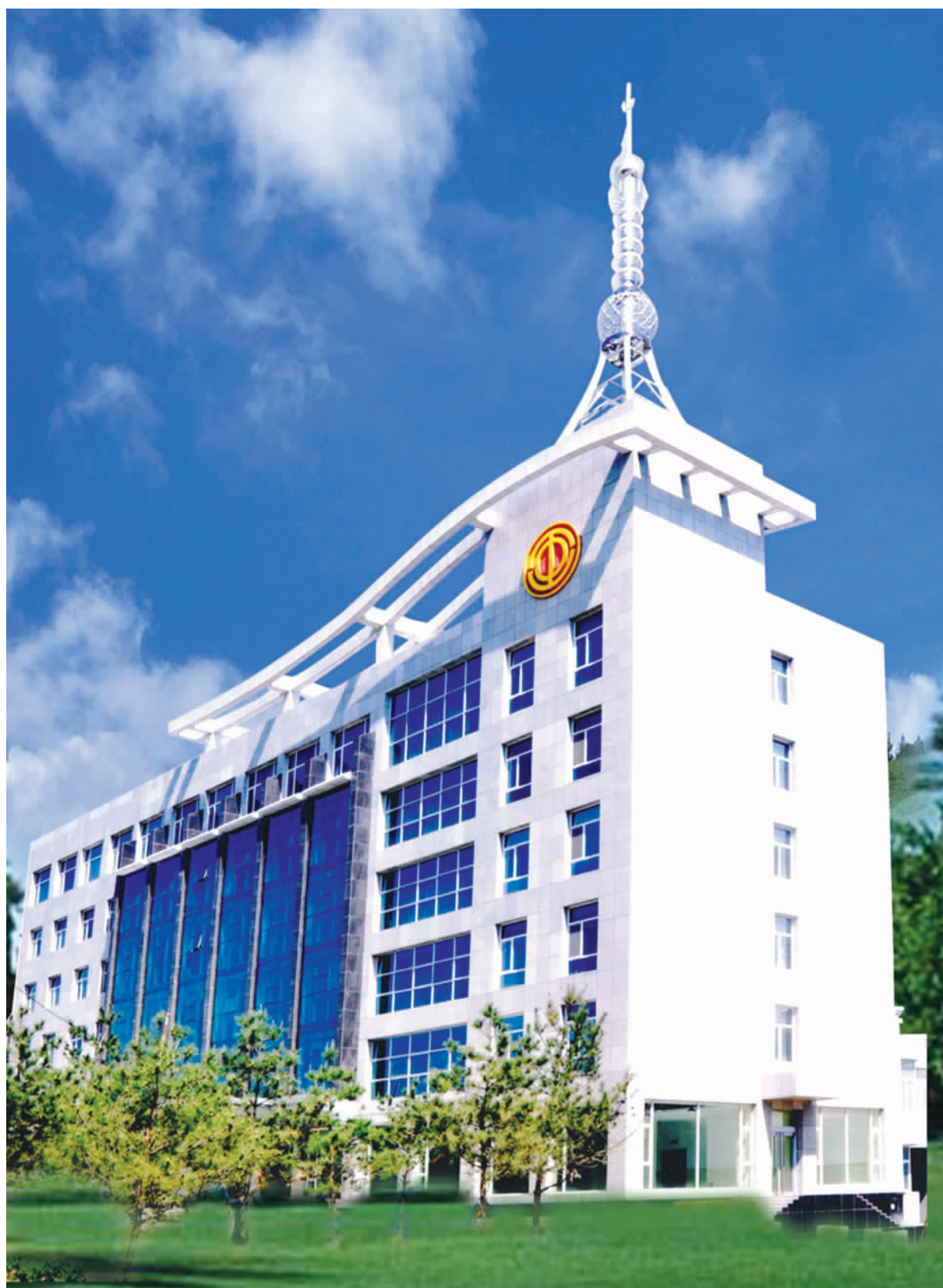
孟县总工会职工活动中心大楼
