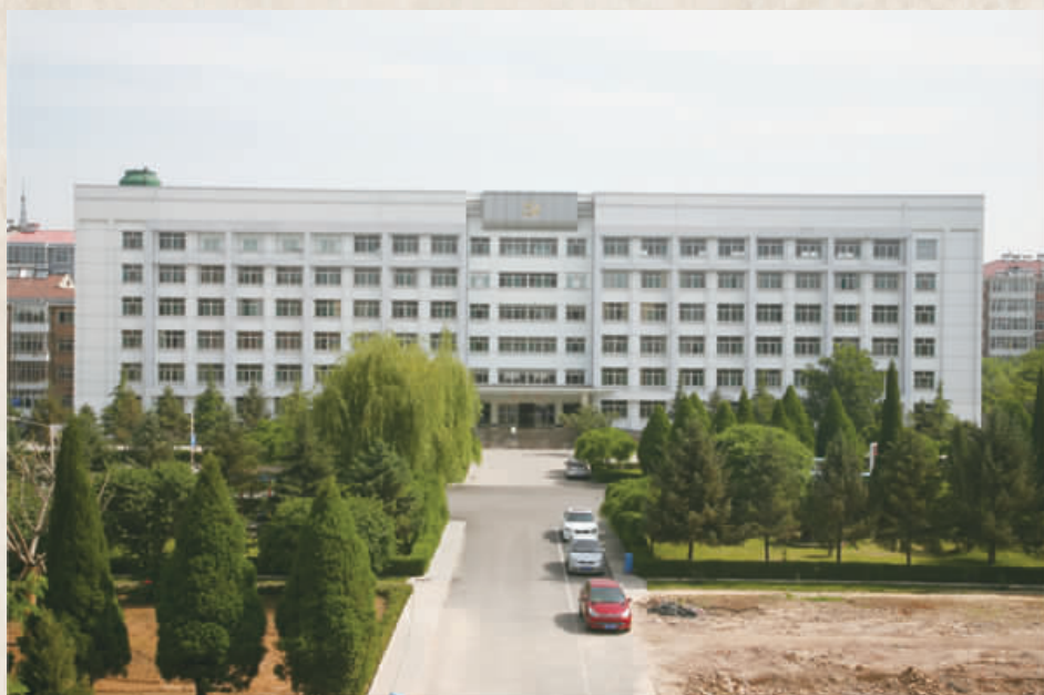
2006年7月竣工的读书楼,投资1700万元,建筑面积10000余平方米
