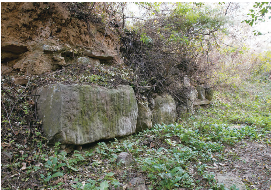
■ 河南济源太行八陉之首轵关陉封门口关隘瓮城城堡的门洞条石基础
