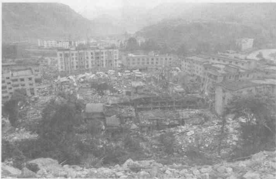
2008年5月15日，四川省汶川县映秀镇，小镇的房屋大面积倾斜坍塌，1万人的小镇仅幸存3000余人。摄/吴海浪
