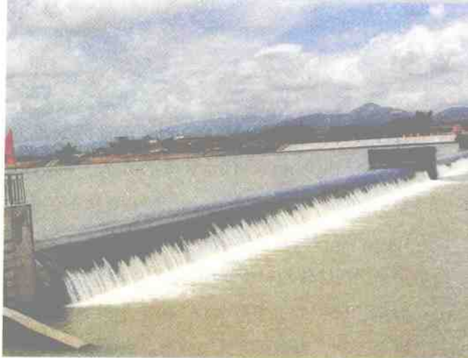
诏安县的水利工程
