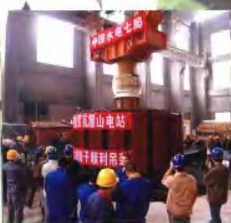
省台机组270吨转子吊装成功
