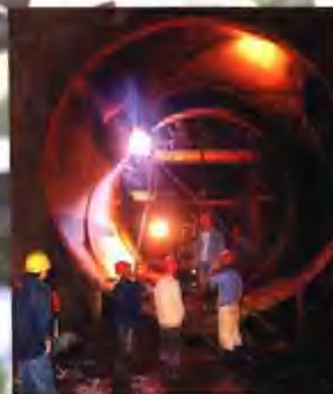
内径6.2米的压力钢管施工
