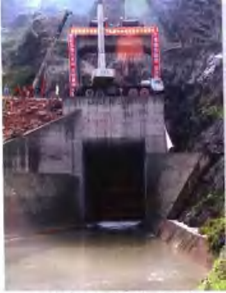
2007年4月10日10时，瓦屋山水电站成功下闸蓄水。
