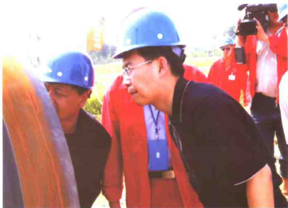
中油集团公司副总经理、股份公司高级副总裁苏树林在施工现场查看管道内涂层
