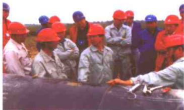
中油股份公司天然气与管道分公司副总经理丁建林（中）和北京华油天然气有限责任公司副总经理、陕京二线项目经理部经理张余（右）现场检查
