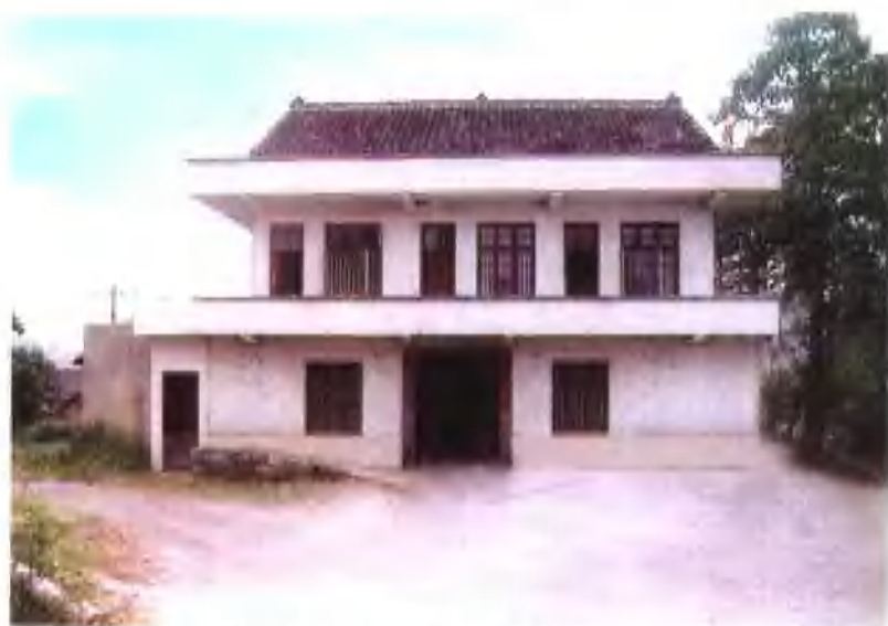
廉桥人民印刷厂（儿子的厂房）
