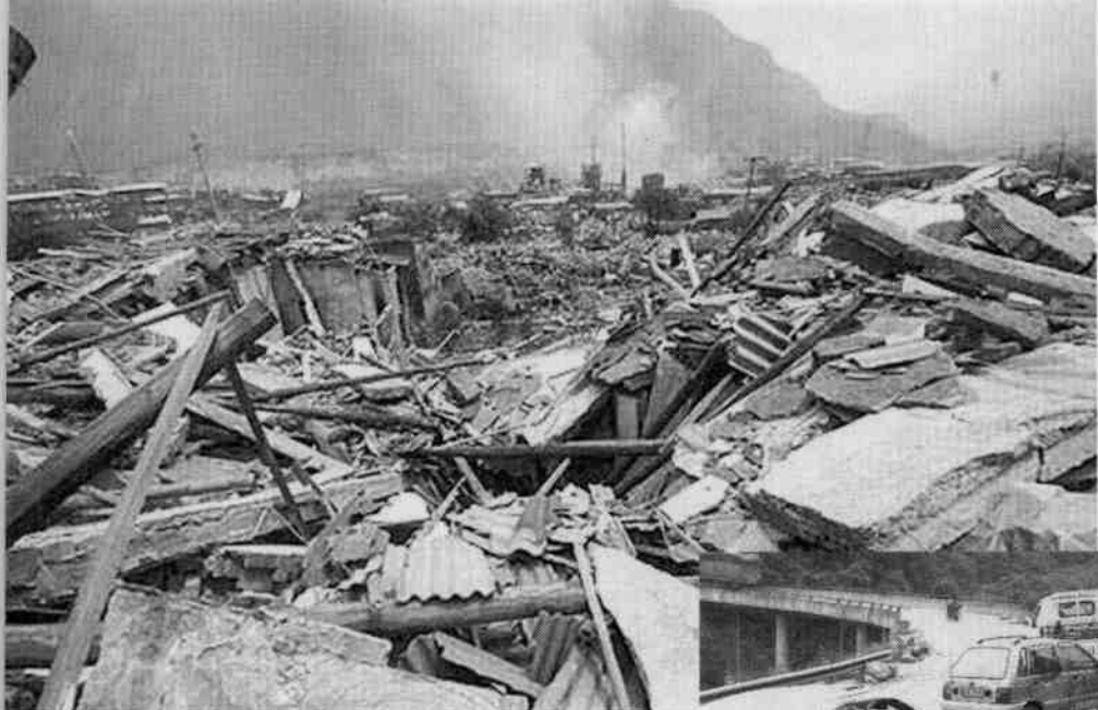
地震后,大片房屋成废墟
