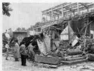
四川绵竹市武都镇的“千年古刹”吉祥寺前门已经垮塌
