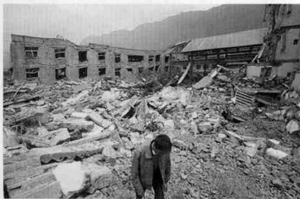
震后,残垣断壁
