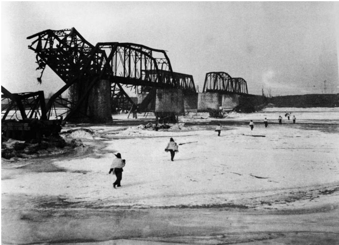
鸭绿江上被炸毁的铁路桥
