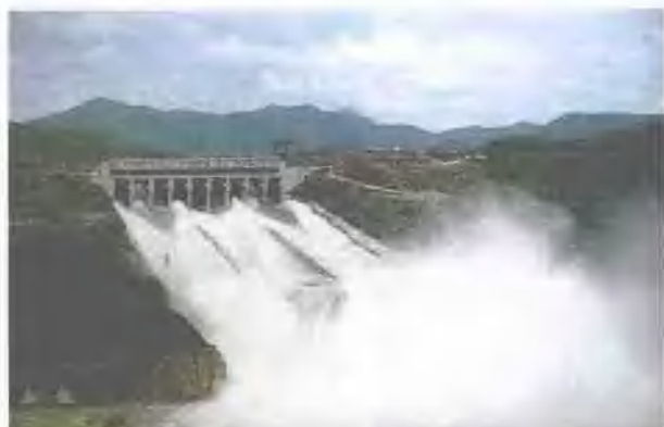
升钟水库泄洪
