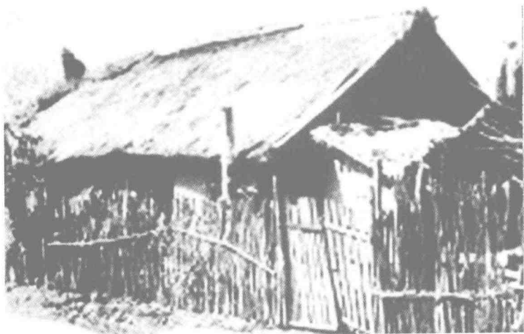
1947年，迁入延寿县中和镇的北大荒第一垦荒指挥所
