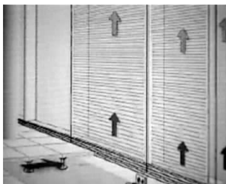
■ 主动和互动式建筑表面利用太阳辐射热和过多的内部热量产生的热气流来形成上升空气幕
