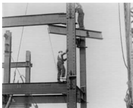
■ 建造摩天大楼要依靠结构钢
