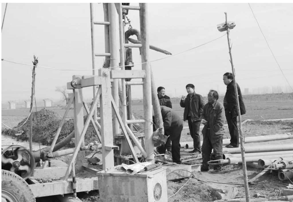
基层建设年活动工作组现场督导打井工作，为驻村打下四眼灌溉深井
