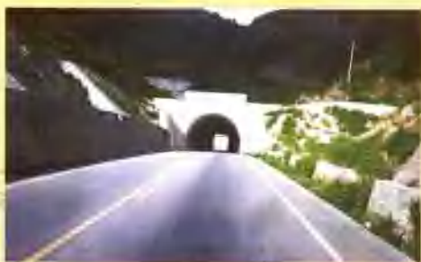
南永二级公路
