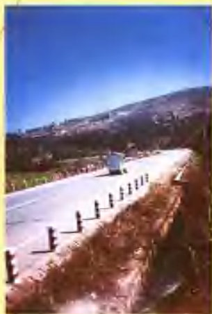
禄武二级公路
