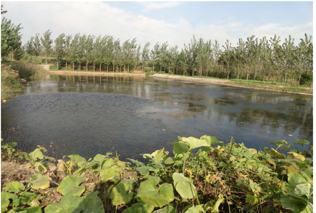
改扩建后的蓄水池
