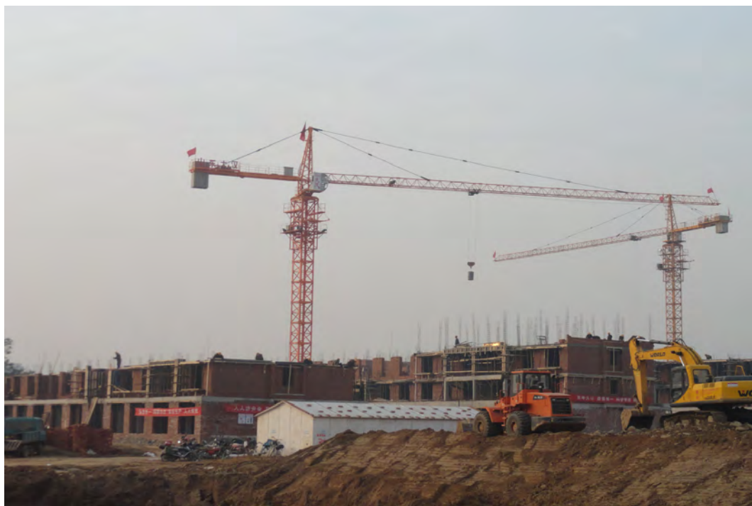
建设中的“翰林官邸”小区
